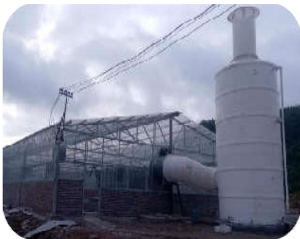
图 61 尾气收集除臭设备
