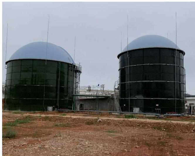
图 17 UASB 厌氧发酵罐
